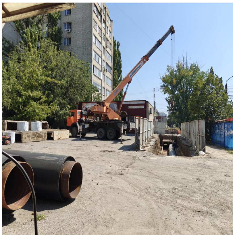
Ремонт тепловой сети Ø159 L=277 м от котельной по ул. Котлостроительная, 23-10
