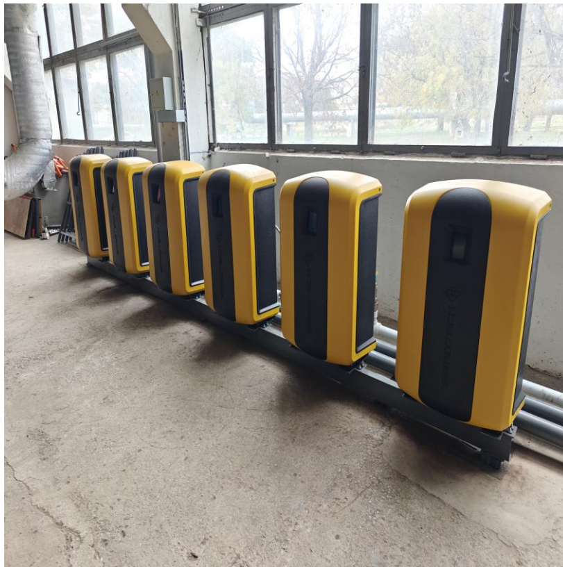
Установка вакуумных деаэраторов на котельной Чучева,3а
