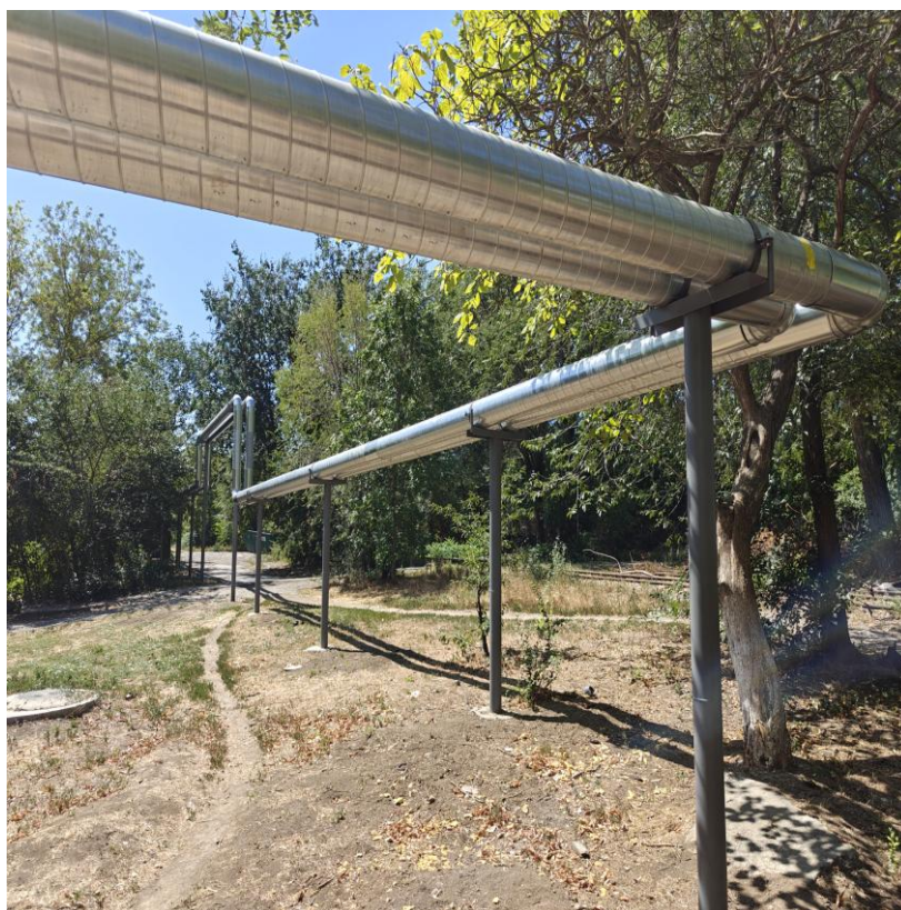
Ремонт тепловой сети Ø159 L=277 м от котельной по ул. Котлостроительная, 23-10
